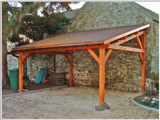
Construction annexe adossée à façade
