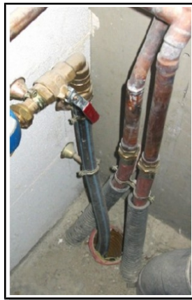
Exemple d'entrées de réseaux à calfeutrer
