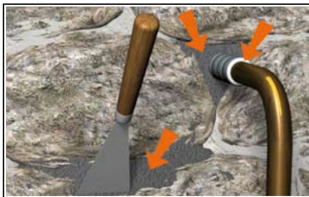
Situation après travaux de colmatage
